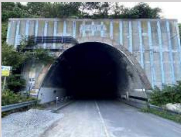
【TC4】旧塩谷 T L=541m 1960,S35 ・曲がって光が見えない
