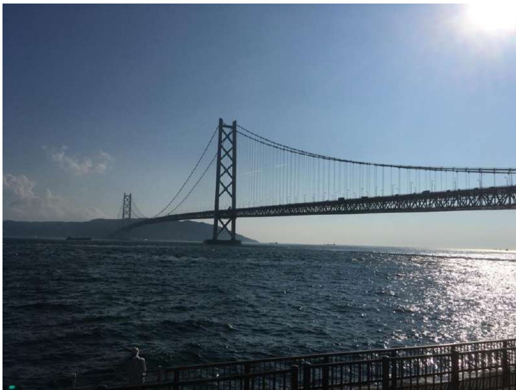
明石海峡大橋
